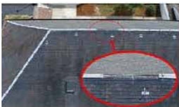
Inspection de toiture
